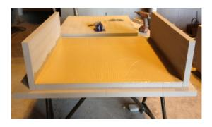
Renforts intérieurs de 200 mm pour les sections supérieures à 500x500 mm entraxe 500 mm. Vissage par vis bois (VBA) 4x40 mm pour les couvres joints en 130x25 mm.
