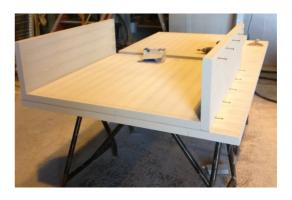
Application au rouleau laqueur sur les parois internes de la colle réfractaire ATHERMAFIX, à raison de 150 grammes au m² (après dépoussiérage de la surface et bouche pores).
