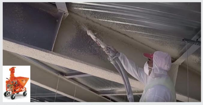
Une mélangeuse fonctionnant en continu adaptée à tous les mortiers secs (Plâtre, ciment, etc...)
